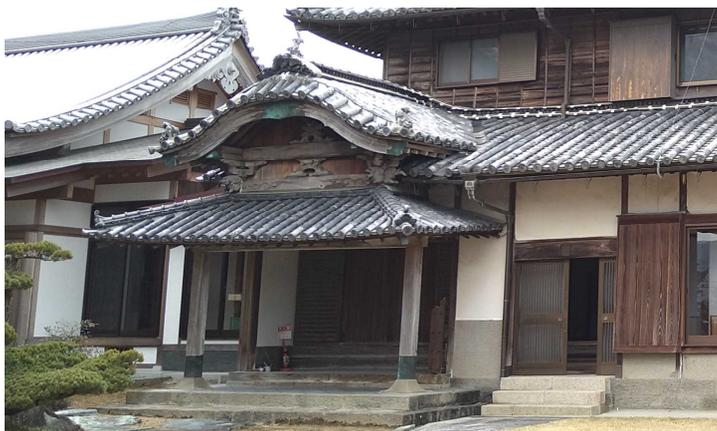
新たな庫裏の玄関は古い庫裏の大玄関の雰囲気を残し、一部古材を再調製している。古い大玄関にはソウやシシの彫刻がなされていたが虫食いの損傷が激しく再利用は不可能かと思われたが、宮大工の手によつて修理が施されよみがえっている。
